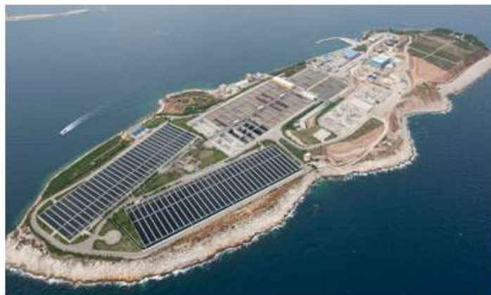
Εικόνα 28. Εγκατάσταση επεξεργασίας λυμάτων στην Ψυττάλεια
